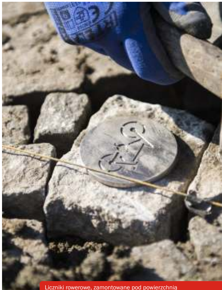
Liczniki rowerowe, zamontowane pod powierzchnią drogi, liczą przejeżdżających rowerzystów
